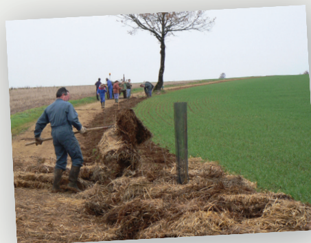
Mise en place de la paille de blé
