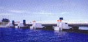
Déversoir du Maresquier
