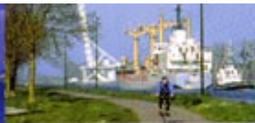
Pont de Bénouville
